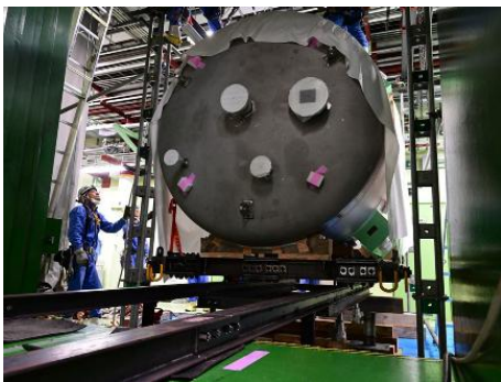
写真4 STACY 更新炉のダンプ槽 (軽水減速材貯水槽) 搬入の様子
