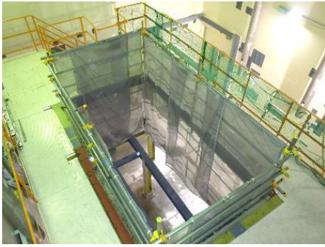
写真2 解体撤去された溶液系 STACY (炉心タンク周辺)
