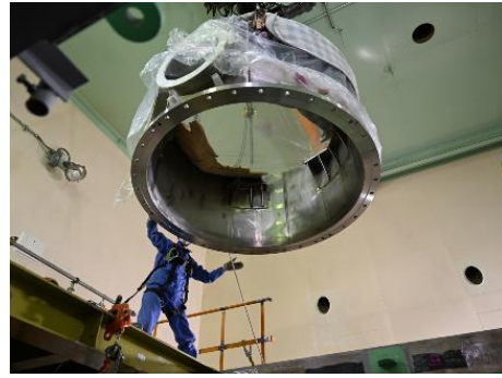
写真3 STACY 更新炉の炉心タンク (上下2分割の上側) 設置の様子
