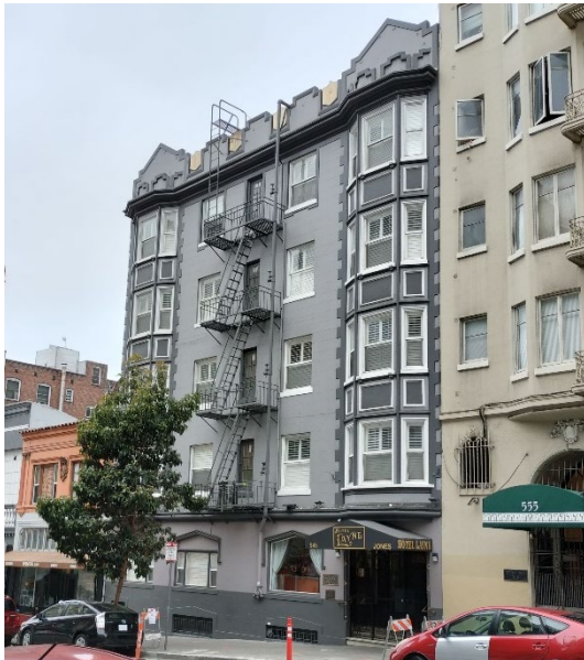
私が宿泊したホテルの外観。入り口には黒い嚴重な鉄格子がはまっている。この付近の建物には鉄格子が目立った。
