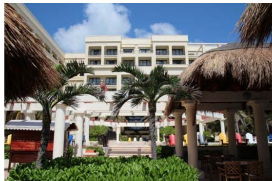
ビーチ側からのホテル外観
