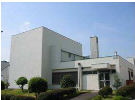
図-1 NCA 建屋の外観
