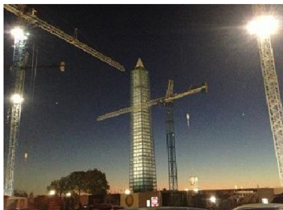
写真1 ワシントン記念塔は工事中・・・
